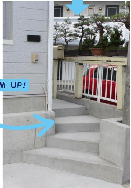
階段は以前のタイル仕上げから、コンクリート仕上げにしました。工事に伴い、ポストも玄関近くに移動。
