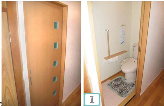
トイレの扉は、以前の開き戸から引き戸に。扉の開け閉めの際に発生する、体の移動が少なくなるように配慮しました。もちろん、室内に手すりを設けて、体をしっかり支えます。
