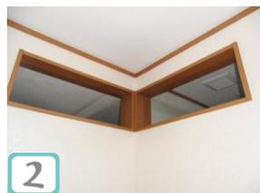
トイレの天井付近に、はめ殺し窓。隣の部屋から見えず、採光を少しでも確保。
